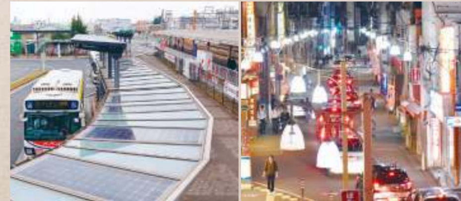
太陽光パネル設置(東松山駅東口ロータリー)
