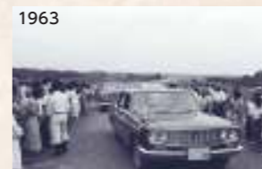
東松山橋完成
