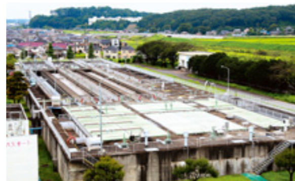
■ 下水をきれいにして川に戻す市野川浄化センター 家庭や工場から出される排水や雨水を受け入れ、さまざまな工程を経て浄化した水を川に戻しています。
