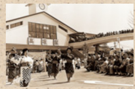
昭和61年 高坂駅舎完成
