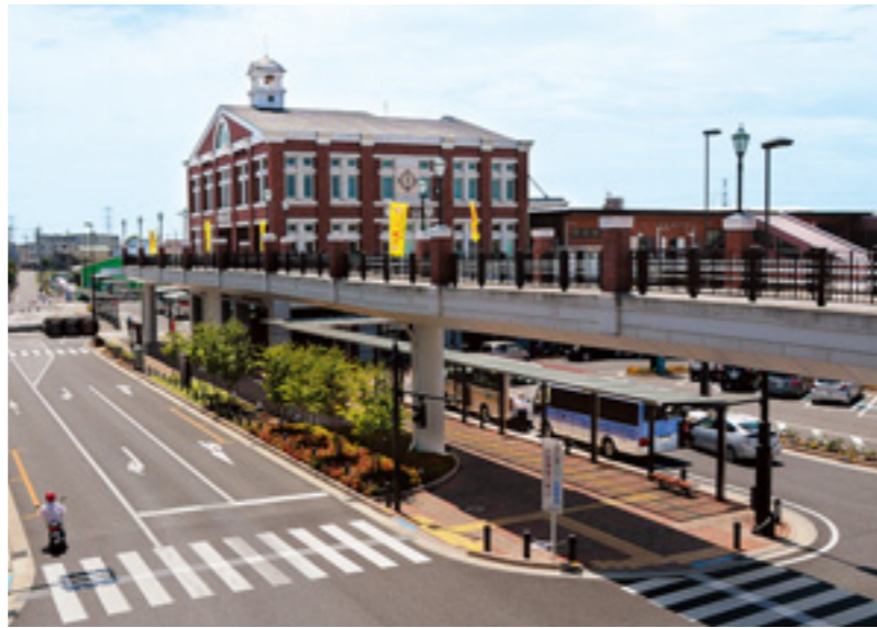
■ 安全と利便性を備えた東松山駅東口前の道路 東松山駅東口にアクセスする2本の都市計画道路は、道幅を広げ、自転車や歩行者も安全に通行できるよう整備を進めています。
