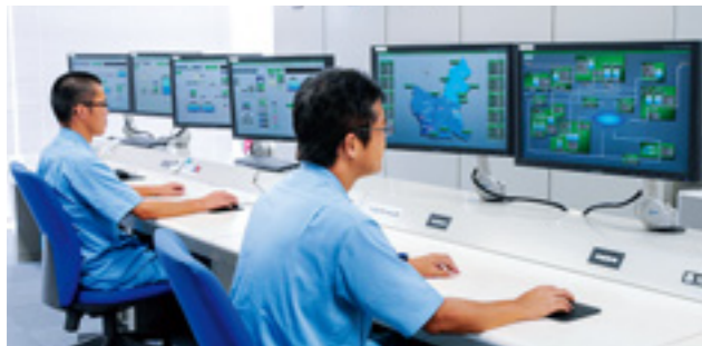
■ 安全な水を市民に届ける水道事業 安全な水を安定的に供給するため、流量や水質などを常時管理しています。また、古くなった水道管を計画的に入れ替え、危機に強いライフラインの確保に努めています。
