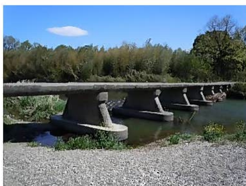
都幾川に架かる稲荷橋
