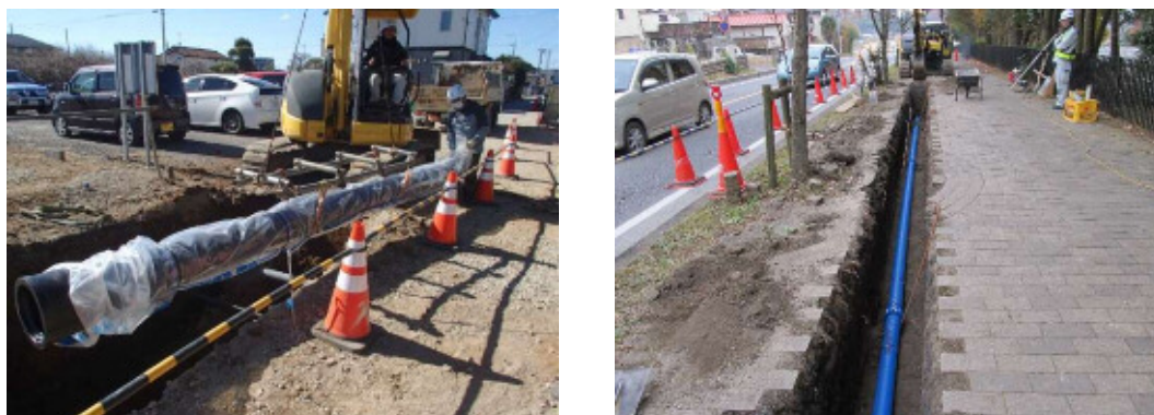
図 4-4 老朽管更新工事の様子
