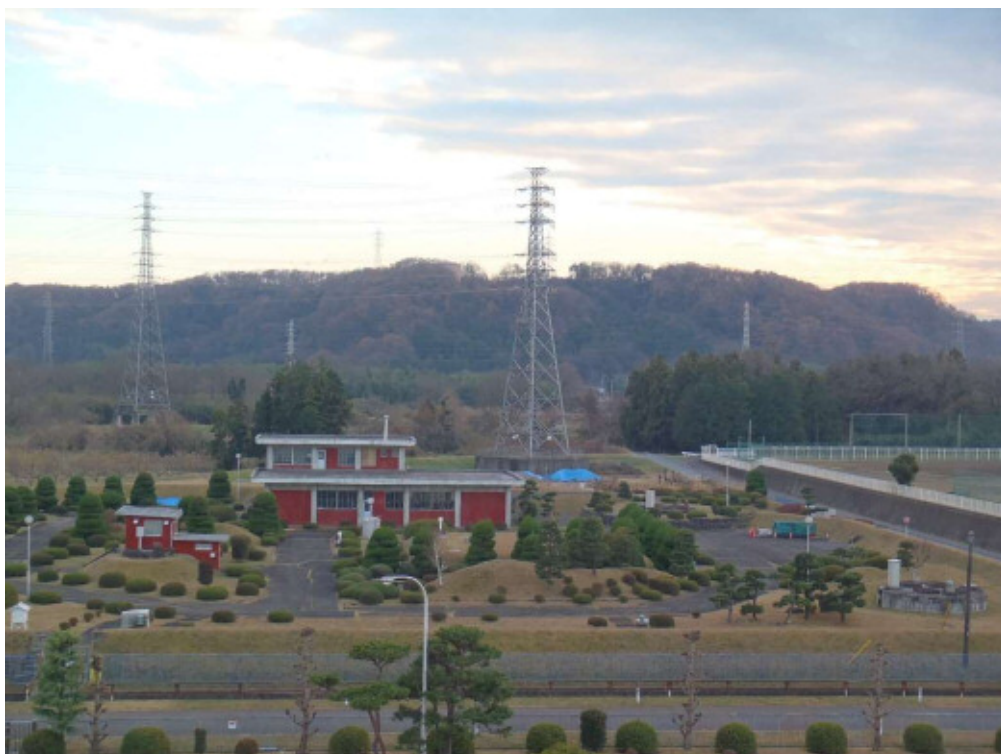
図 4-6 第一浄水場の様子
