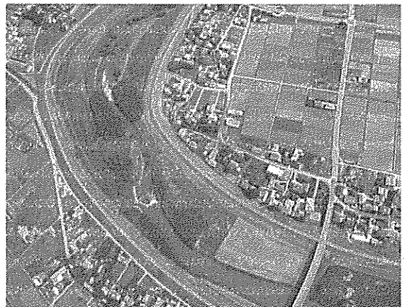
上空から高野橋下流を見る
