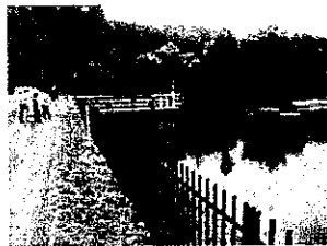
堰堤・立樋・安全柵
