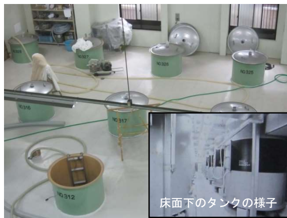
図 4.4 近代化された現在の仕込みタンク群 (高さ：約 4m、容量：12000ℓ)
