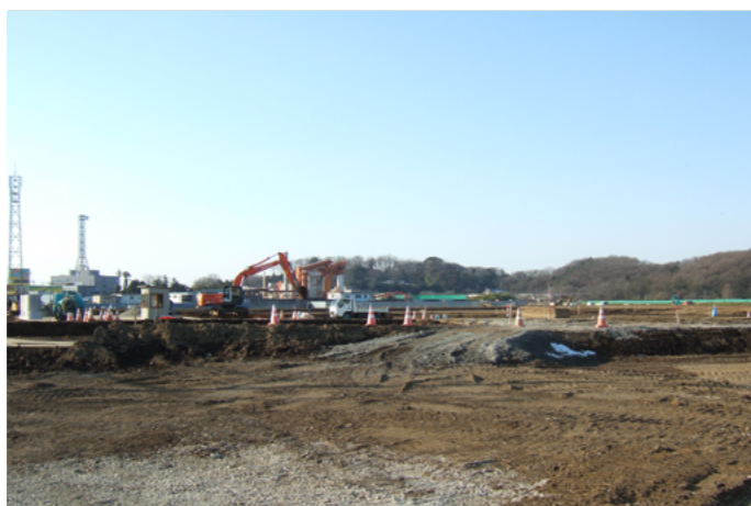
造成が進む藤曲地区
