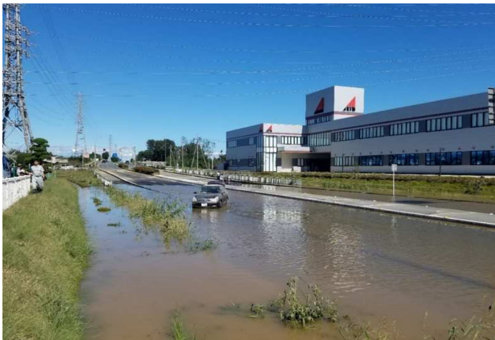
国道407号 高坂市民活動センター付近
