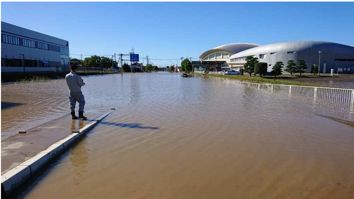
国道407号 高坂市民活動センター付近
